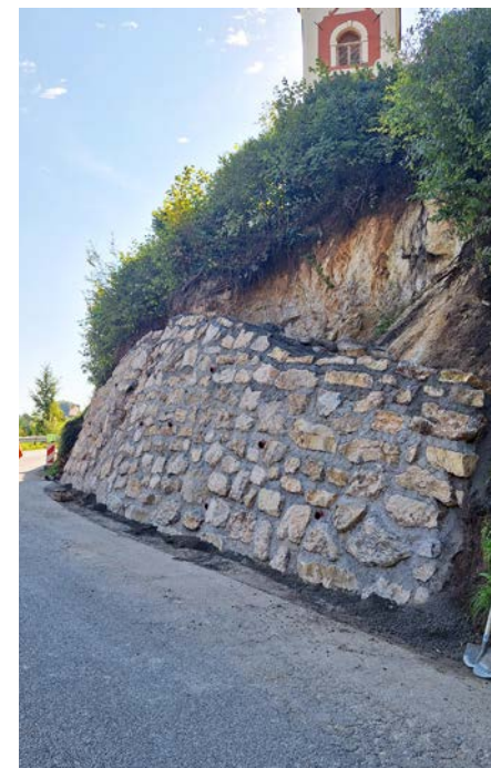
Oporni zid Sveti Peter
